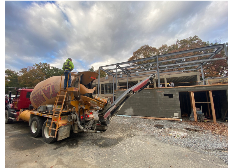
Rear Addition Concrete Deck Pour
